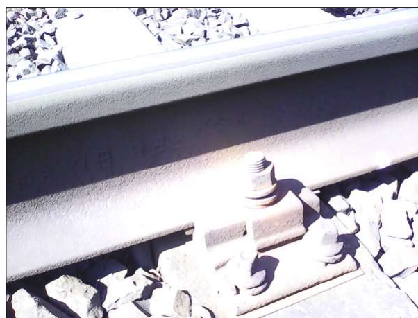
Detail železničního svršku, sm. Ústí n/L (R65)
