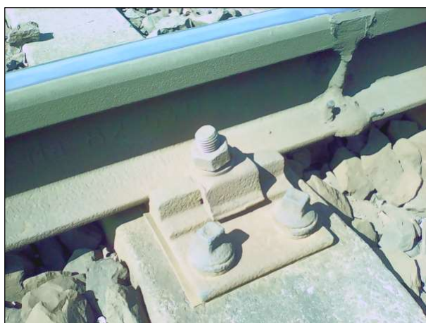
Detail železničního svršku, sm. Most (S49)
